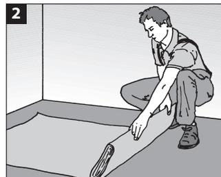
**2** Grundsätzlich ist bei Estrichen und bei Verlegung auf Fußbodenheizung eine 0,2 mm starke PE-Folie auszulegen. Diese soll im Stoßbereich 30 cm überlappen. Anschließend die Folie im Wandbereich hochziehen und nach der Sockelleistenmontage an der Oberkante abtrennen.
